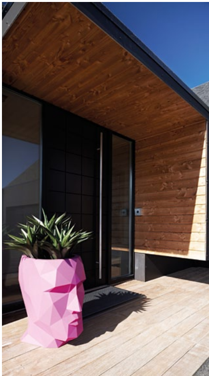
Protection pluviale. Située au nord, l'entrée est abritée par un auvent qui redescend vers le sol sans l'atteindre.
