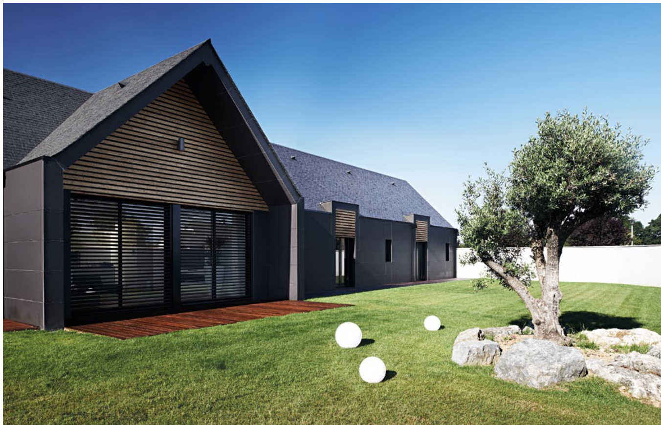
Invisibles. Les pignons de la maison en façade ainsi que les lucarnes qui encadrent les baies vitrées permettent de dissimuler élégamment les brise-soleil escamotables à lames orientables.
